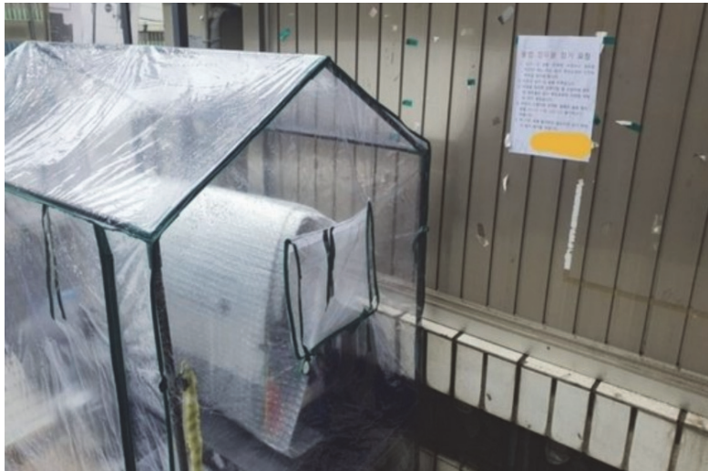
〈그림 7〉 불법 점유물이 사유지에 설치된 모습
